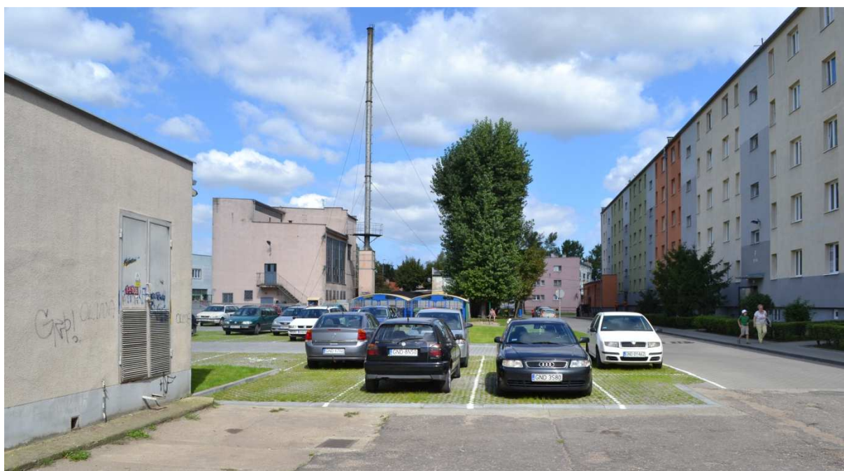
Rysunek 21. Widok na ciepłownię od strony południowej
