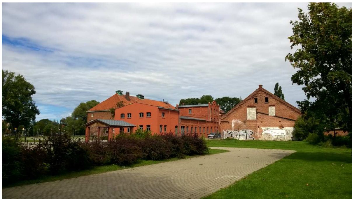
Rysunek 8. Widok na przestrzeń publiczną za budynkiem Żuławskiego Parku Historycznego od strony rzeki
