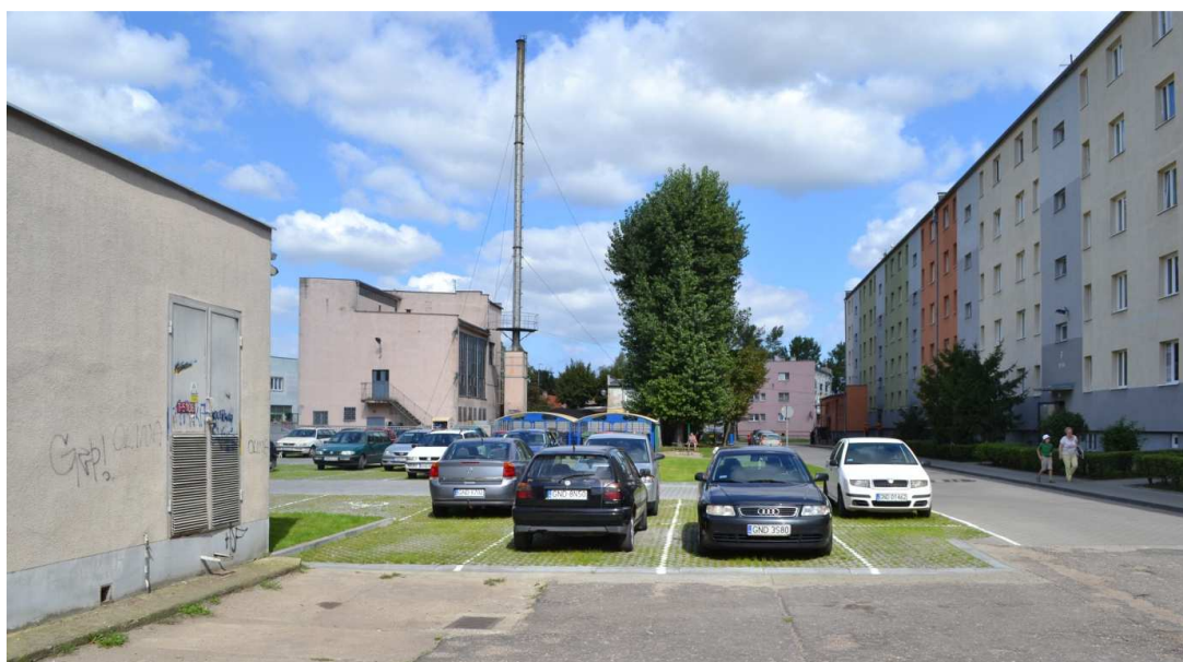
Rysunek 21. Widok na ciepłownię od strony południowej
