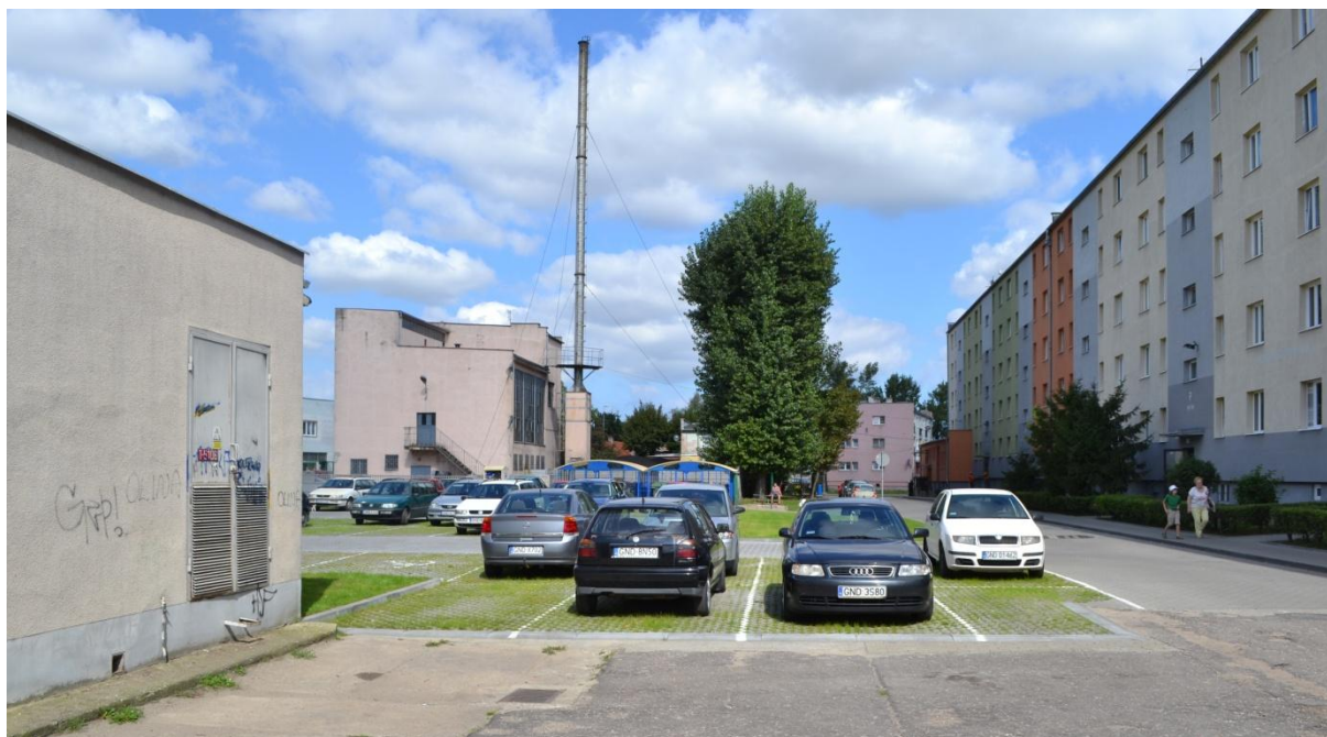
Widok na ciepłownię od strony południa
