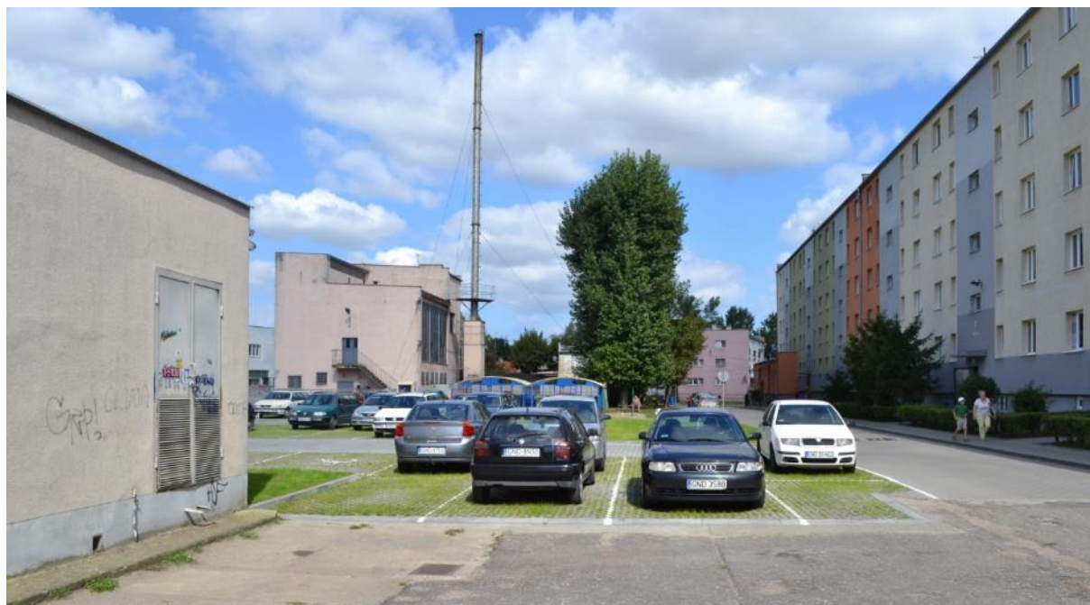
Widok na ciepłownię od strony południa
